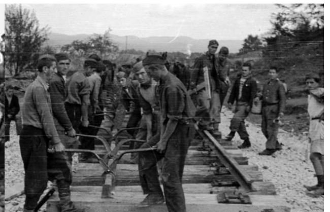
Izgradnja pruge Šamac-Sarjevo
